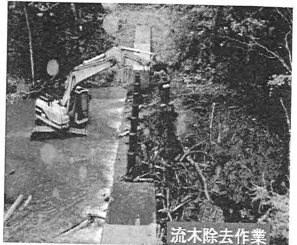
(写真-3・流木除去作業)
