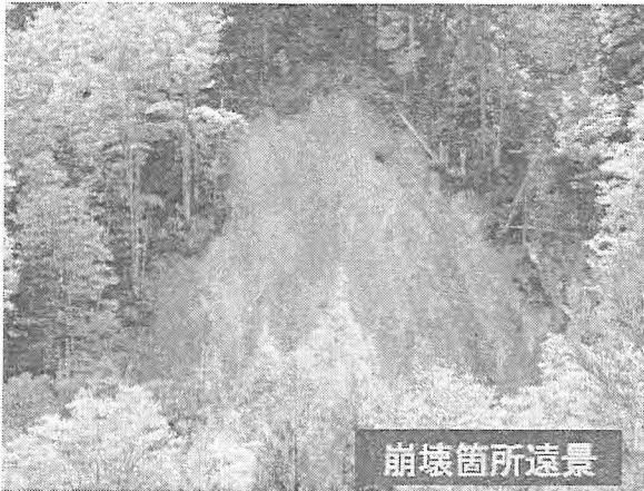
(写真-6・崩壊箇所遠景)
