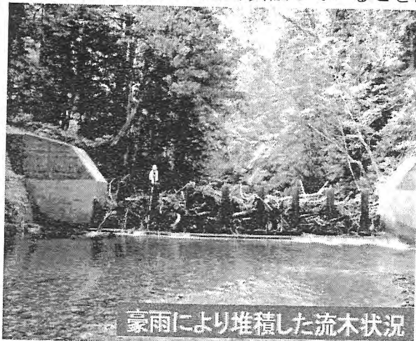
(写真-2・堆積した流木状況)
