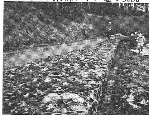
パネル式特殊フトン籠の現況
