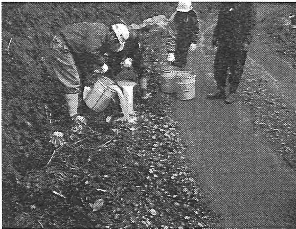
透水試験状況
