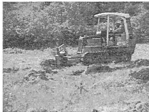
写-2 小型ブルドーザーによる掻き起こし
