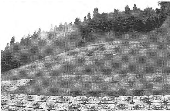
写-7 緑枠内が植物誘導吹付工
