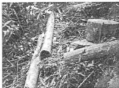
写真1 登山道の損傷
