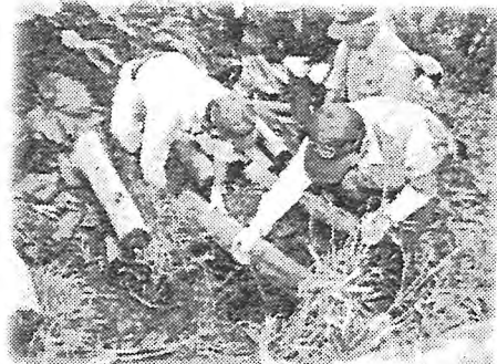
写真6 丸太の階段工を設置する作業
