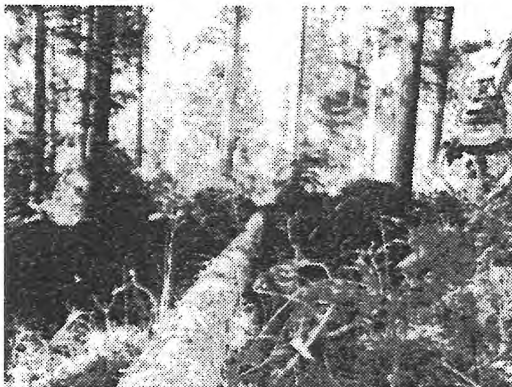
写真-4 伐採作業の状況
