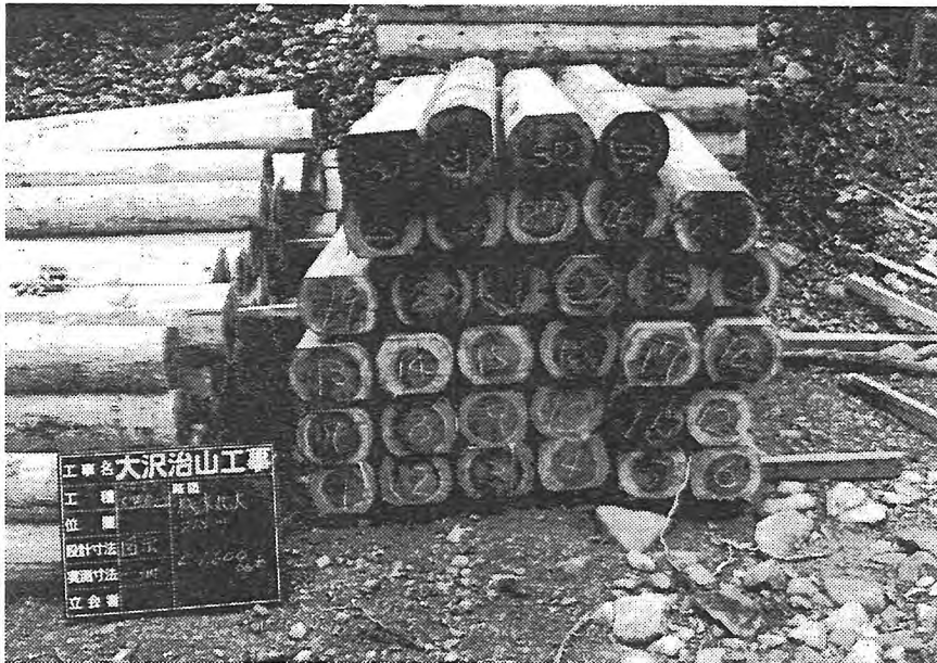
写真-3 太鼓落とし加工した木材
