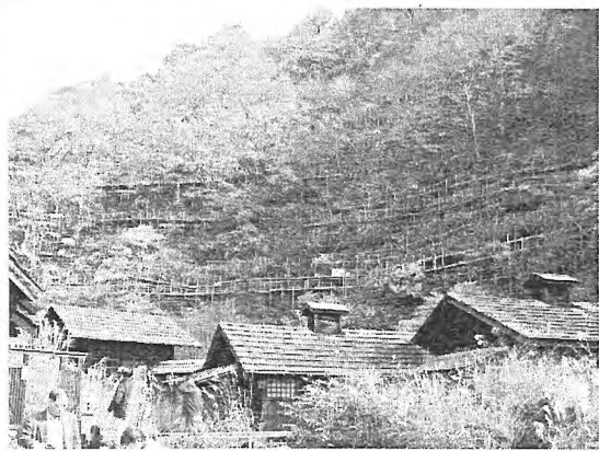
写真-6 温泉施設と足場施設
