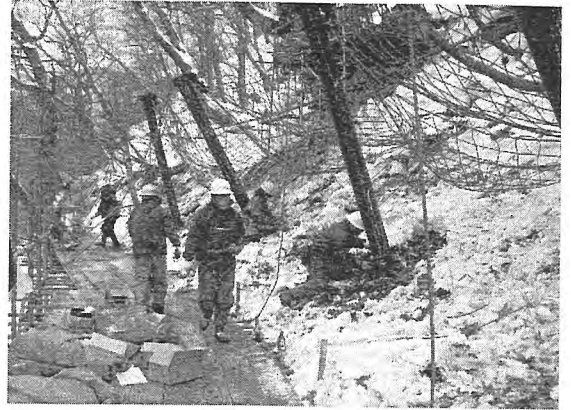
写真-8 各ロープ取付け状況
