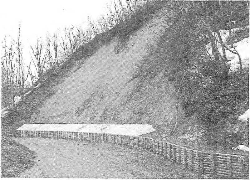
丸太柵片側護岸工による復旧状況
