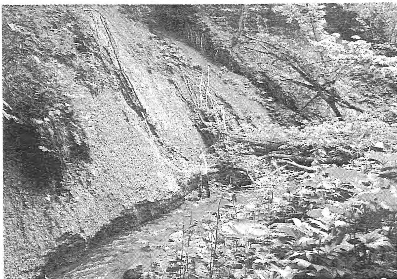
溪岸崩壊と溪床洗屈状況
