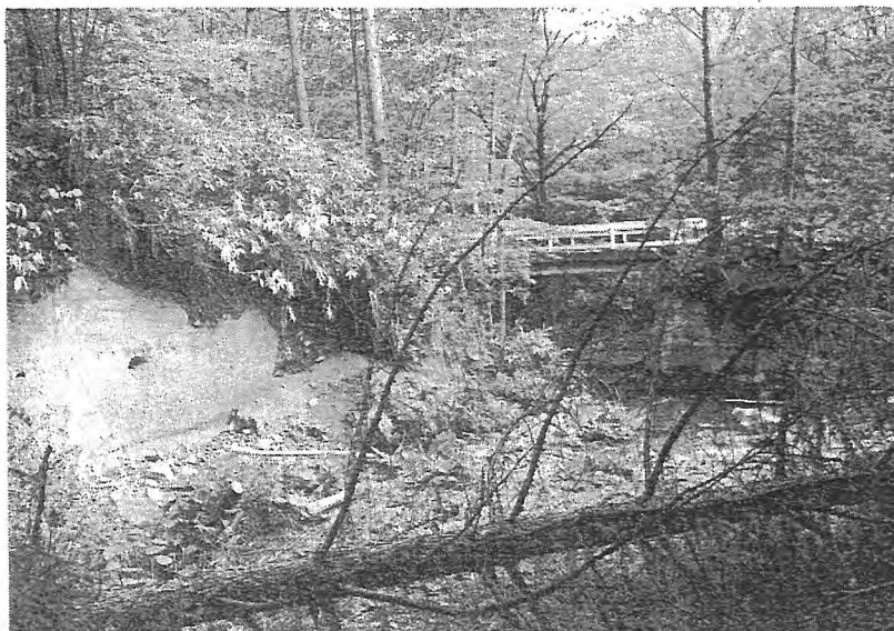
国道104号線と熊取沢荒廃状況
