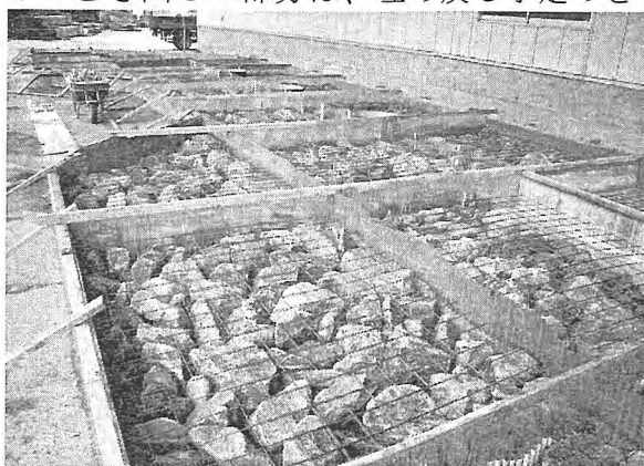
石材を使用した型枠の製作
