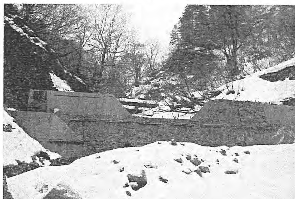
施工中のNo.1 谷止工
