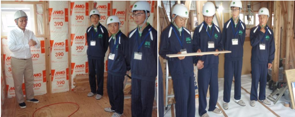
写真－5 住宅建築現場の見学
