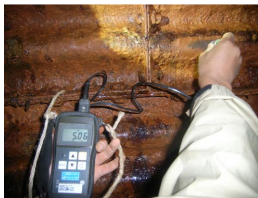
写真－14 測定状況
