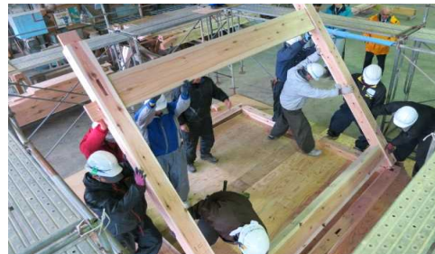
【金物を使わない小屋組み実習】
