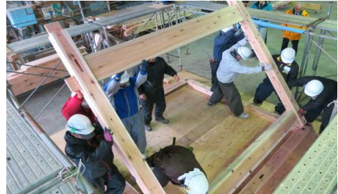
【金物を使わない小屋組み実習】
