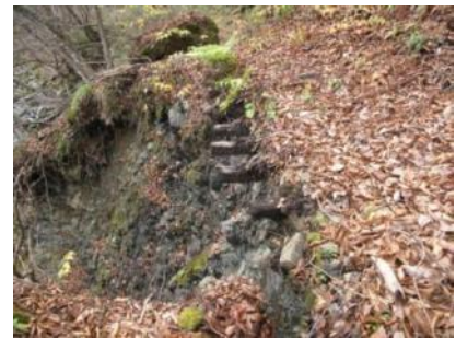
図7 枕木の残った路面
