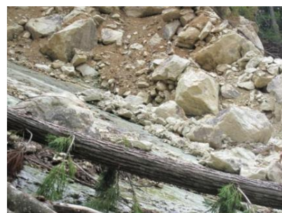
図 5 太良峡 崩壊箇所の様子
