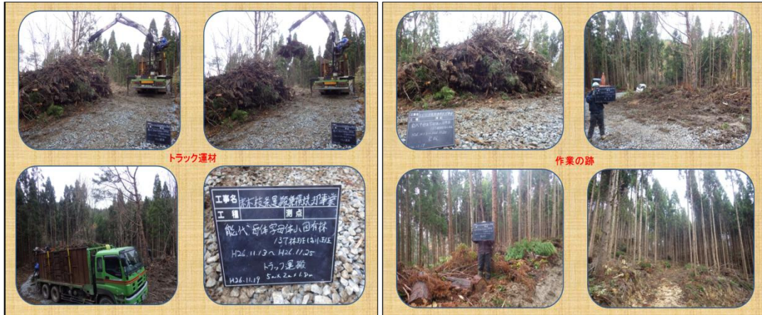
図-5 トラック運搬中の様子
