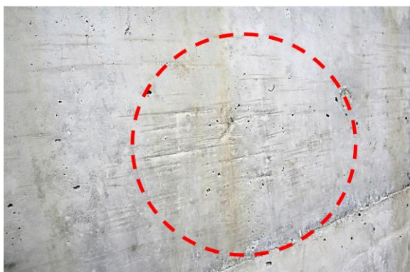
図4 型枠剥離後のコンクリート表面
