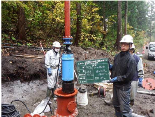
写真1・2 スーパーウェルポイント工（左：揚水管挿入、右：設置完了）
