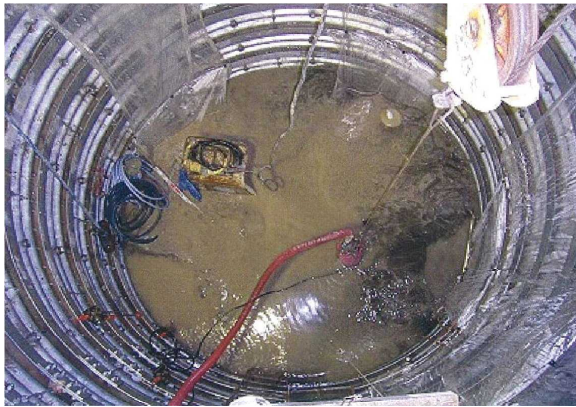
写真4・5・6・7 井壁崩壊発生状況
