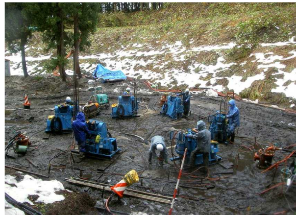
写真3 薬液注入工実施状況
