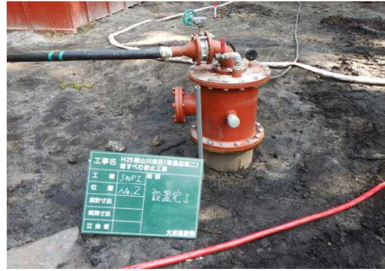
写真1・2 スーパーウェルポイント工（左：揚水管挿入、右：設置完了）
