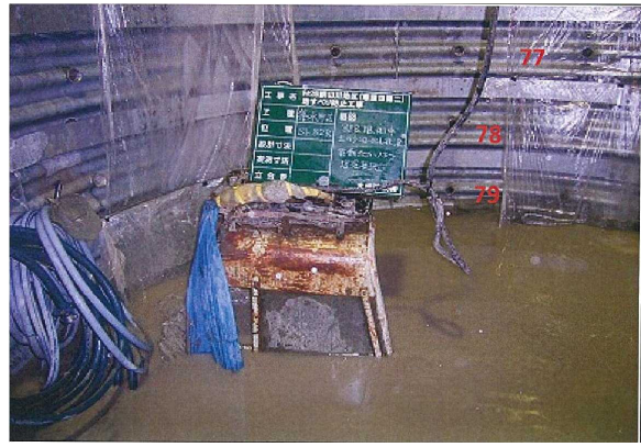
写真4・5・6・7 井壁崩壊発生状況
