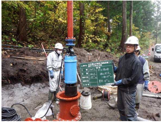
写真１・２ スーパーウェルポイント工（左：揚水管挿入、右：設置完了）
