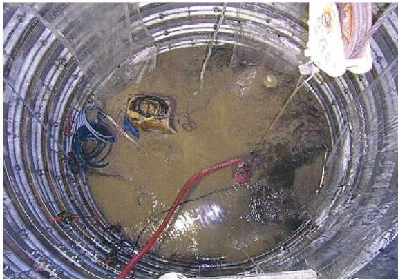
写真 4・5・6・7 井壁崩壊発生状況
