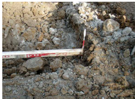
写真4. 施工厚さの管理状況
