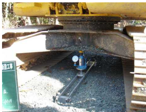
写真5. 支持力の調査状況
