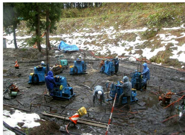
写真３ 薬液注入工実施状況
