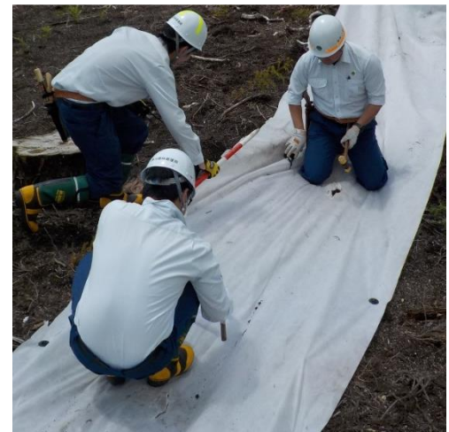
Fig. 7 生分解性シート敷設作業
