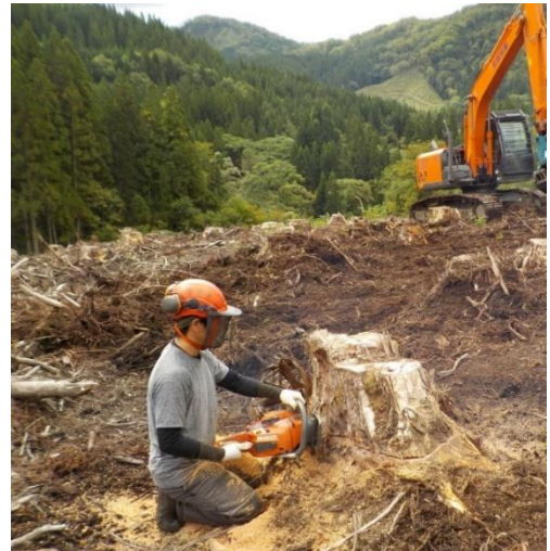
Fig. 6 伐根の切断作業
