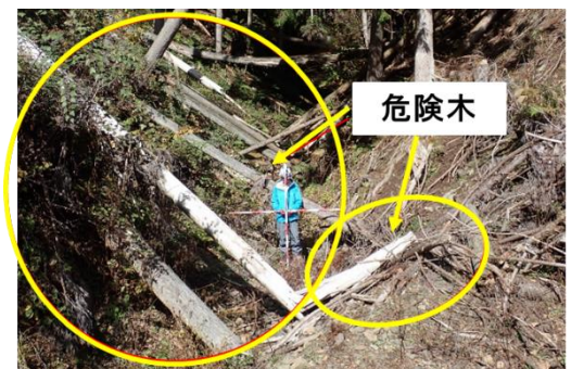
図2：岩井堂沢の施工前の状況
