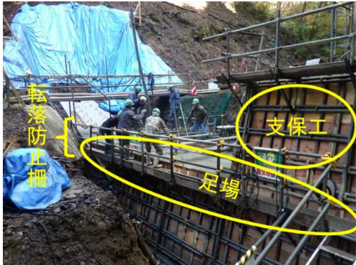
図 10：合板型枠を使用した現場
