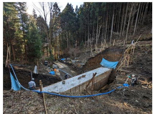
図1：治山現場の状況
