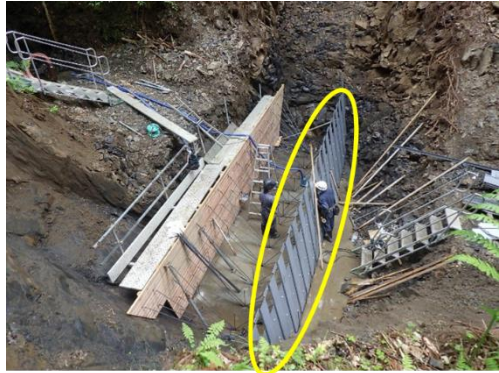
図 11：鋼製残存型枠を使用した現場
