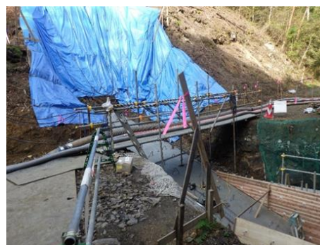
図5：上流側への資材運搬路
