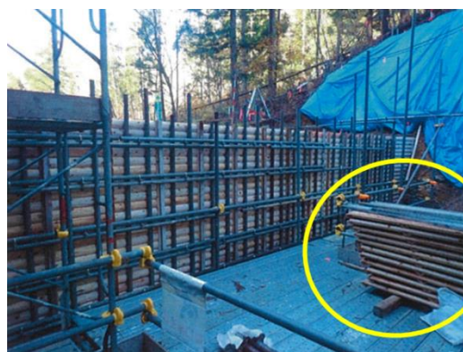
図6：足場を兼ねた資材置き場
