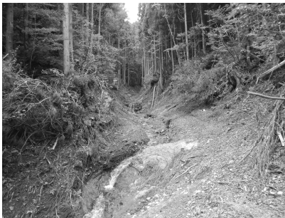
写真－1 溪岸浸食
