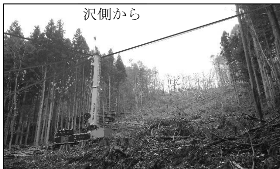
図8 タワーヤーダの設置状況
