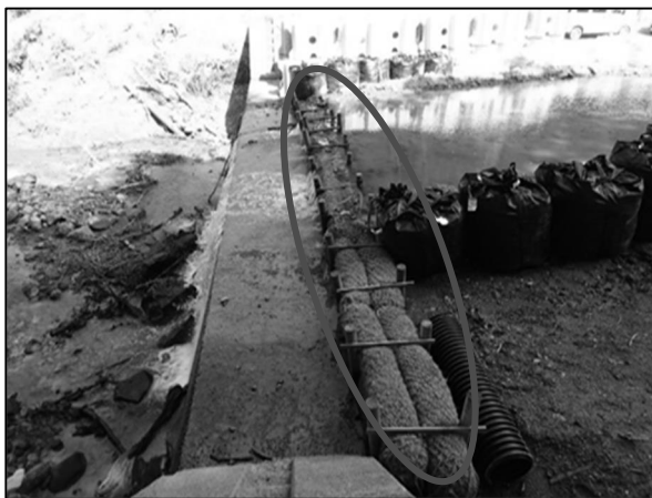
写真１：ヤシフィルターの設置
