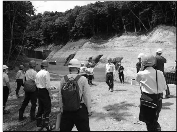
写真5：県の工事現場見学
