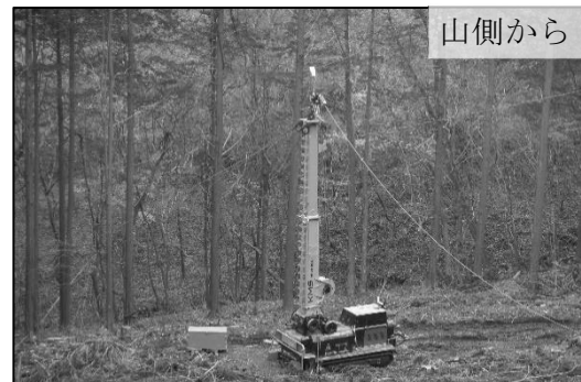
図9 タワーヤーダの設置状況
