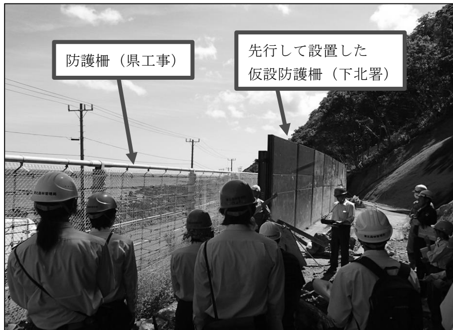
写真3：下風呂（1）災害関連緊急治山工事現場
