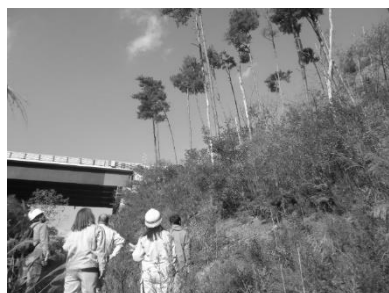
図7：被害状況確認状況
