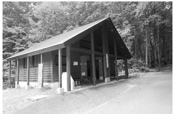
写真-2 公衆トイレ
