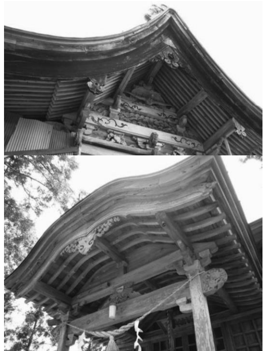
写真4 秋田諏訪宮の破風板
