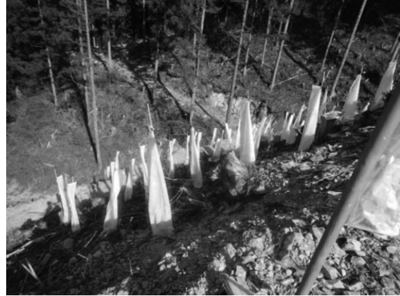
写真-4 設置状況（斜面下部・資材 B） 斜面上部に比べ礫が多い
