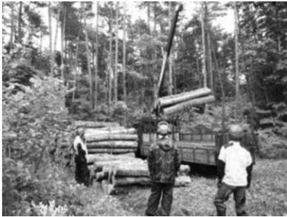
図10：丸太設置作業
