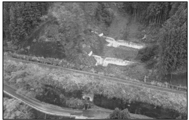
写真7 完成した治山ダム(令和4年11月撮影)
