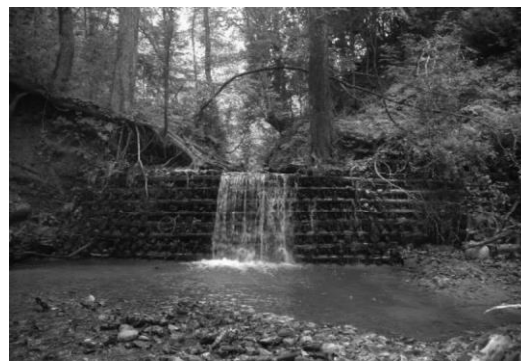
写真 2 坪毛沢ヒバ木製治山堰堤群
