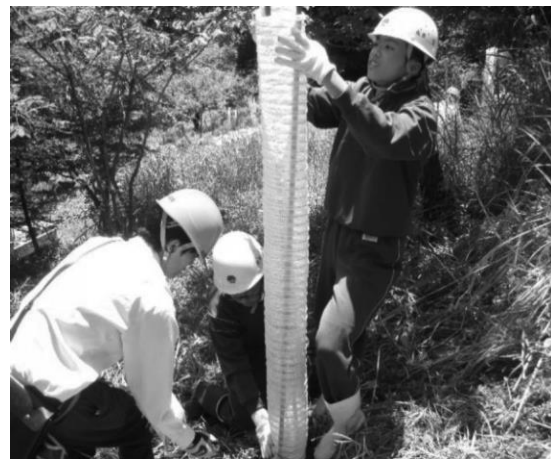
図6：保護管を固定する様子
