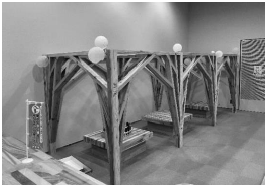
図-16 木もれびの部屋（ビレッジプラザ のレシプロカル架構をイメージ）
