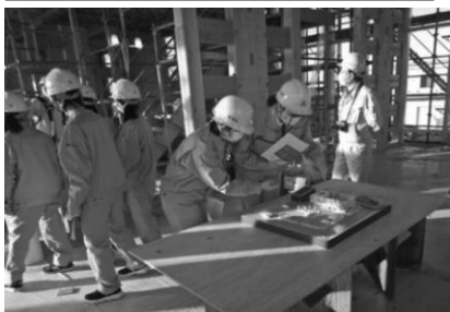
木造社屋の見学（建築中）
