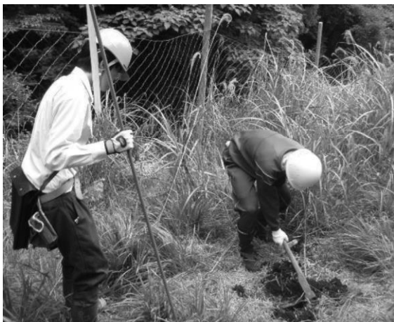
図5：植付箇所の穴を掘る様子
