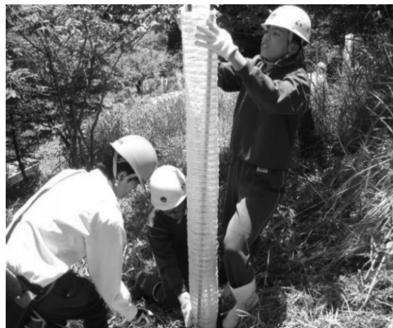
図6：保護管を固定する様子
