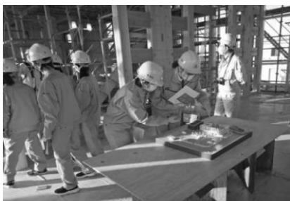
木造社屋の見学（建築中）
