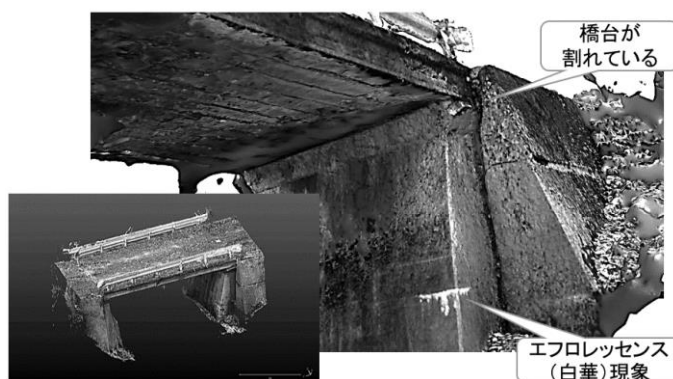
図-10 三次元点群による施設点検
