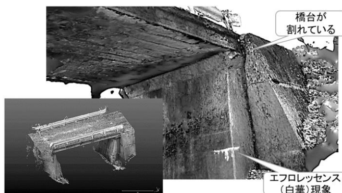
図-10 三次元点群による施設点検
