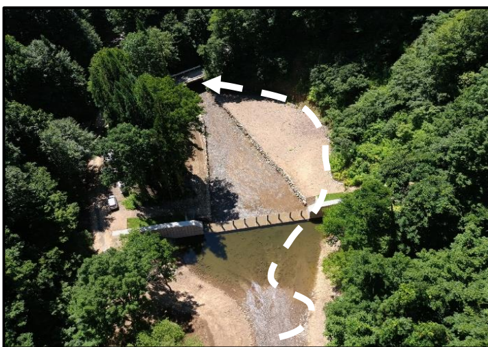
写真－4 2年目完成時
