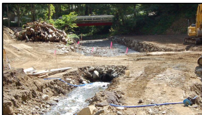
写真－8 沢を跨ぐ迂回路
