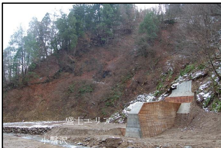
写真－3 1年目完成時
