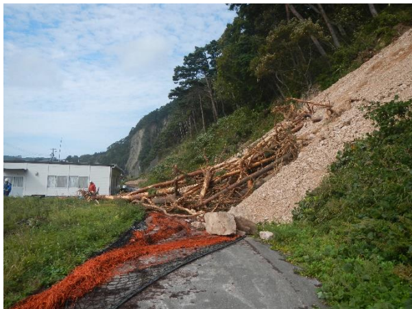
写真2：立木が堆積した被災状況
