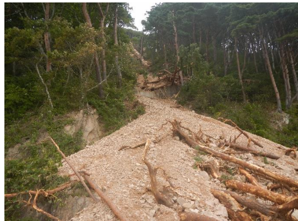
写真3：土砂崩落した被災状況
