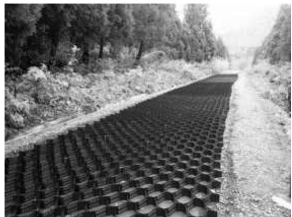
写1—ジオセル工法の施工状況
