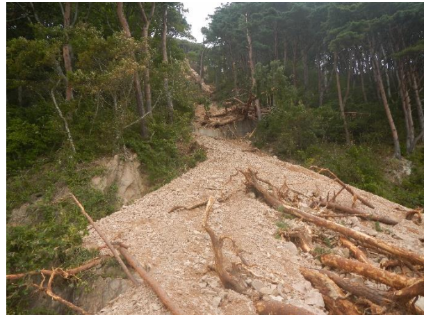
写真3：土砂崩落した被災状況
