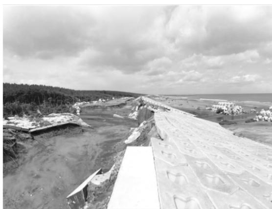
津波が乗り越え被災した緩傾斜堤
