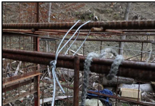
図7. 補強した天井の様子
