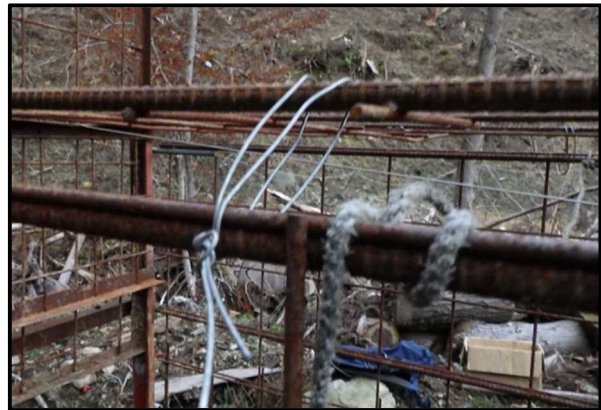
図7. 補強した天井の様子
