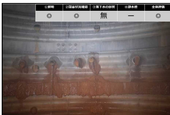
図-10 集水ボーリング 1 段目
