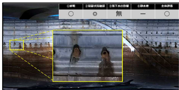
図-14 集水ボーリング 1 段目
