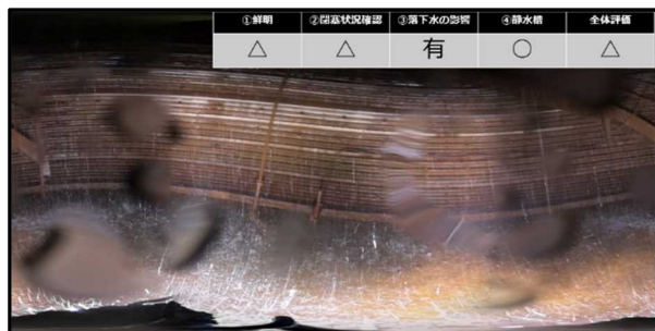
図-16 静水槽付近
