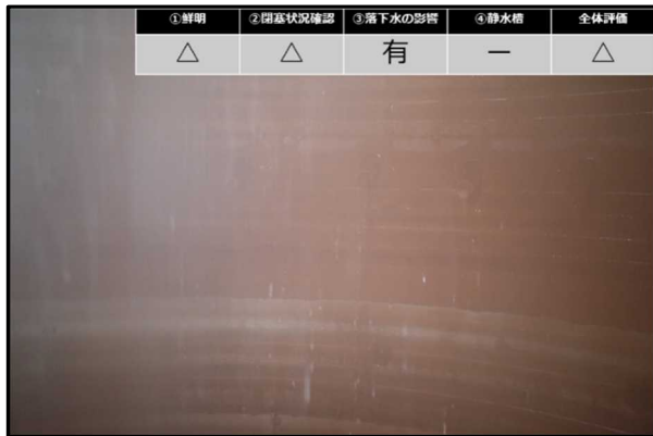
図-11 集水ボーリング 2 段目
