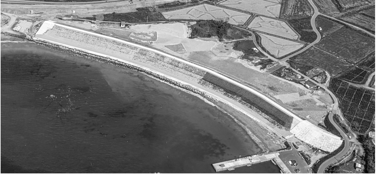
写真－6 堤体完成写真
