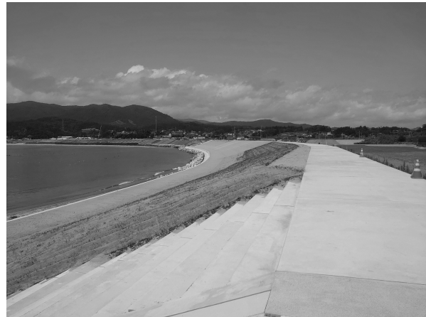
写真－5 防潮堤の覆土
