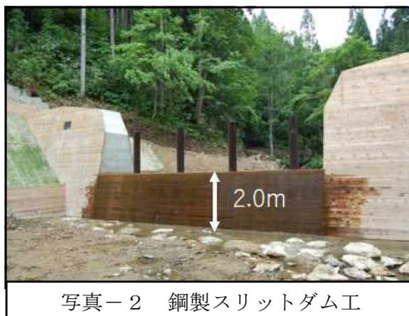
写真-2 鋼製スリットダム工
