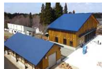
実習棟(手前)と機械 実習棟(奥)
