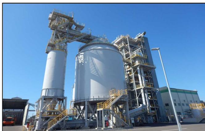
<図2 木質バイオマス発電所>
