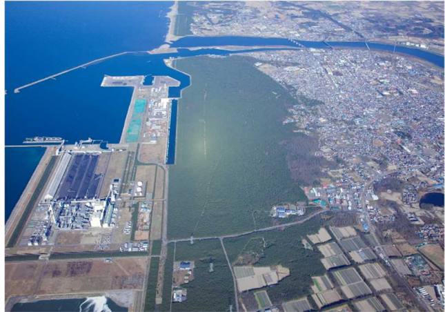
写真-1 風の松原全景
