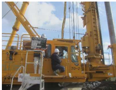
写真-5 モニター確認
