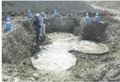
写真-9 改良径確認
