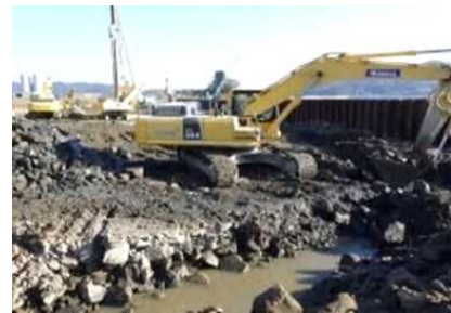
写真-11 撤去状況
