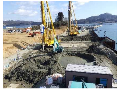
写真-4 ヤード全景
