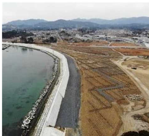
写真-12 堤体完成写真
