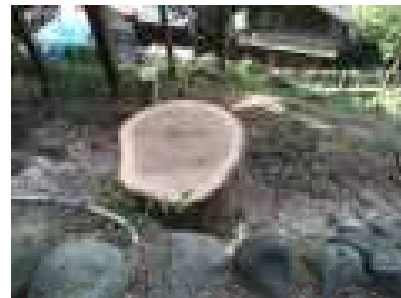
写真2 危険木の伐採現場
