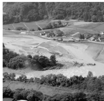
志戸前川下流域の氾濫状況 （平成25年8月豪雨直後、 出典：雫石町広報）
