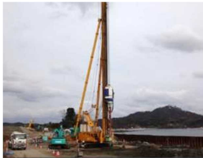
写真-3 地盤改良機
