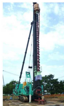
図-10 変位抑制型のエポコラム工法
