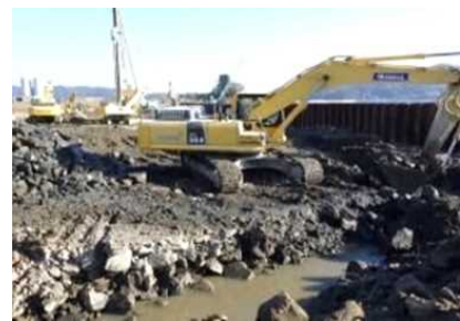
写真-11 撤去状況
