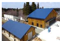
実習棟(手前)と機械 実習棟(奥)
