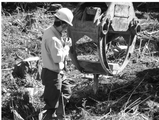
写真1 林業機械を活用した植栽
