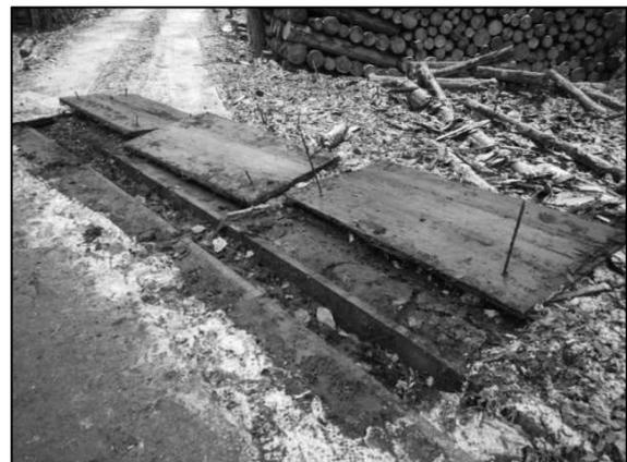
図8 敷設4ヶ月後のCLTと側溝の状況
