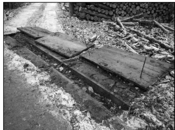
図8 敷設4ヶ月後のCLTと側溝の状況
