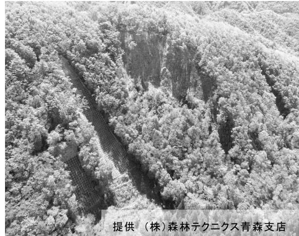
写真 ⑬ 復旧状況 温湯区域
