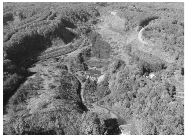
写真 ⑨ 復旧状況 耕英区域 (冷沢)
