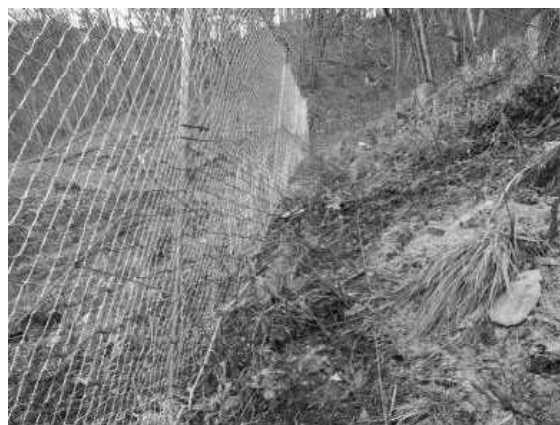
写真－２ PE ネット柵
